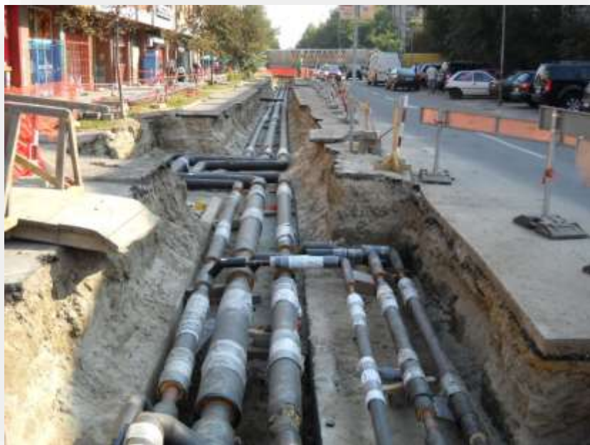
Montaža razvodne mreže
